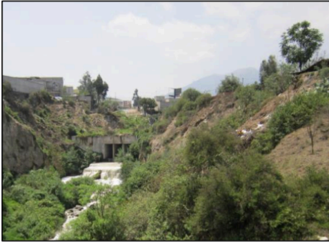
Salida del Colector del Condado, se aprecia que el agua tiene espuma y sedimentos en suspensión, por lo que se halla muy contaminada
