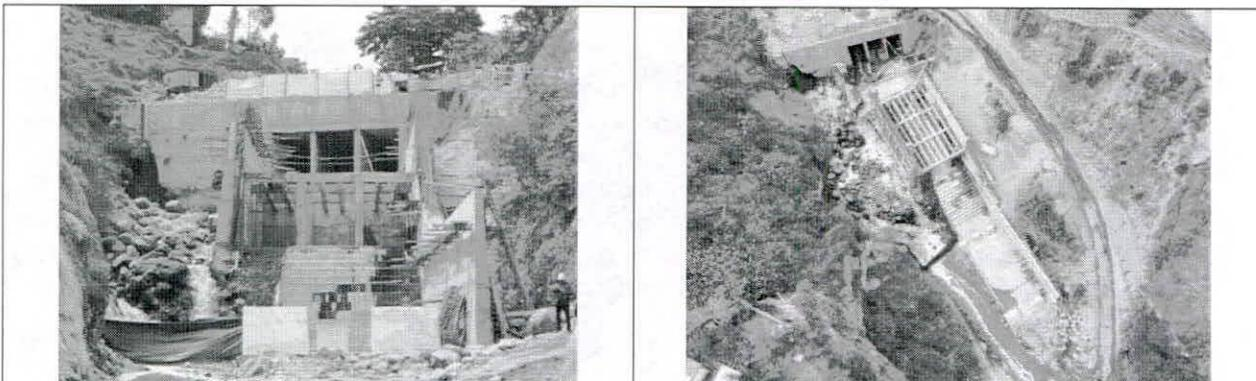
**Foto No. 1:** "CONSTRUCCIÓN DEL DISIPADOR DE ENERGIA DE LA DESCARGA DEL COLECTOR EL COLEGIO". Los estudios y el diseño de este proyecto fueron realizados por administración directa; y actualmente, el proyecto se encuentra en fase de ejecución por un monto contractual de \$2,168,716.29 (DOS MILLONES CIENTO SESENTA Y OCHO MIL SETECIENTOS DIEZ Y SEIS DÓLARES DE ESTADOS UNIDOS DE AMÉRICA CON 29/100 CENTAVOS).
