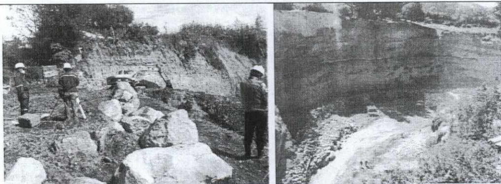
Fotografía 10. Inspección zona No. 1 La Esperanza- obras Emergentes
