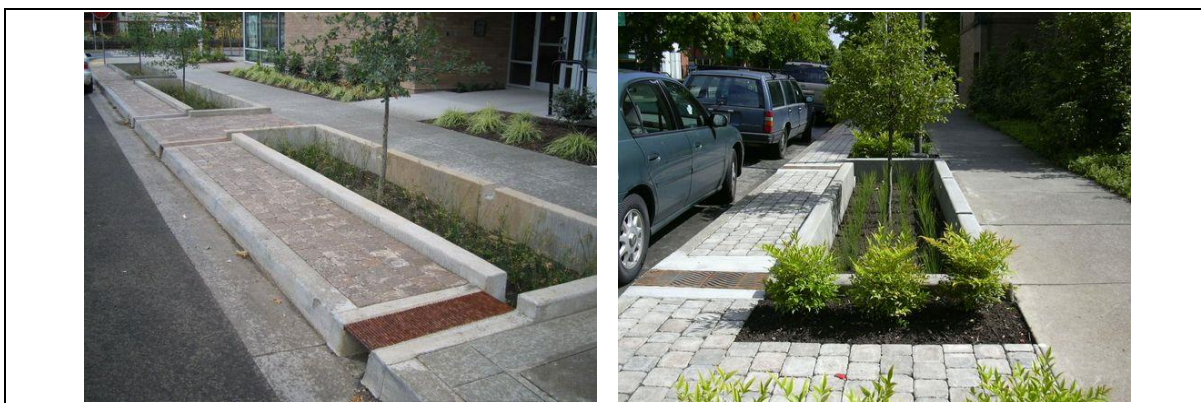
Figura 2.38. Ejemplos de captación en vías públicas
