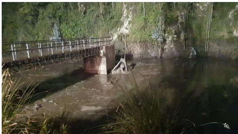
Figura 2.36. Captación quebrada Caicedo
