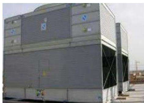
Imagen 6. Condensador evaporativo
