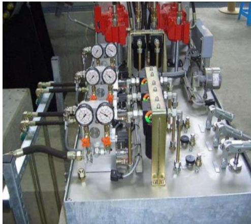
Imagen 3. Gobernador de turbina
