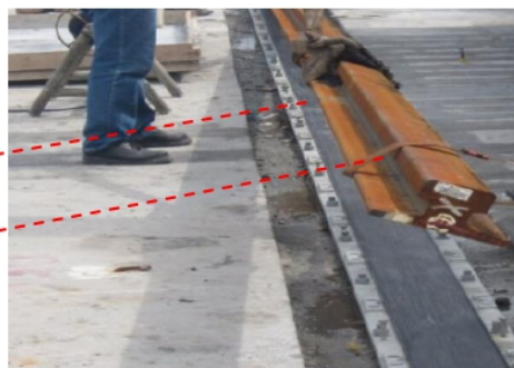
Imagen de referencia, tomada del portal web del fabricante GANTREX, deja ver la forma de instalación del "Sistema de rieles de rodadura para grúa pórtico".
