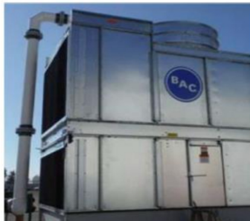
D. Condensador Evaporativo
