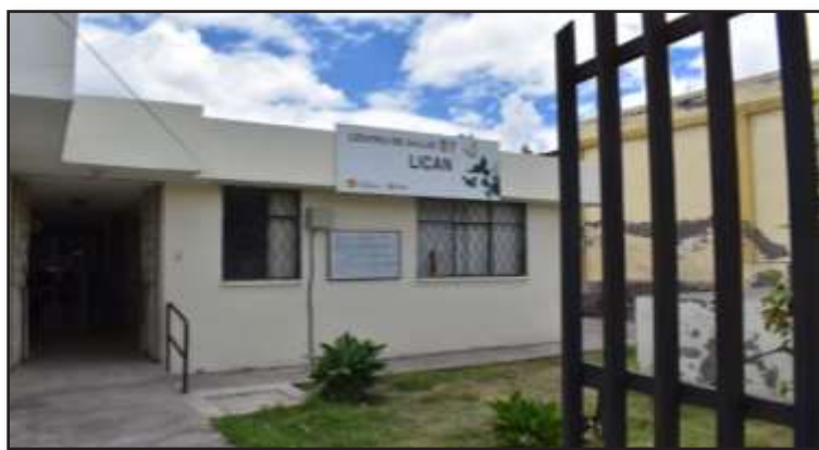
Fotografía N° 29 Centro de salud de Licán
