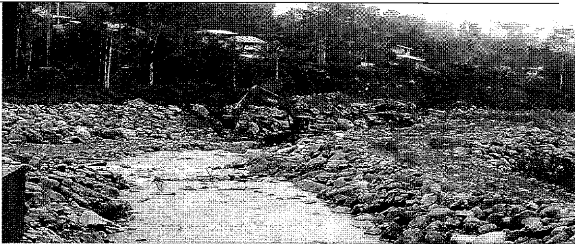
Maquinaria trabajando en la limpieza del lecho del río y construyendo el muro de contención en la ribera izquierda del río (foto 10)
