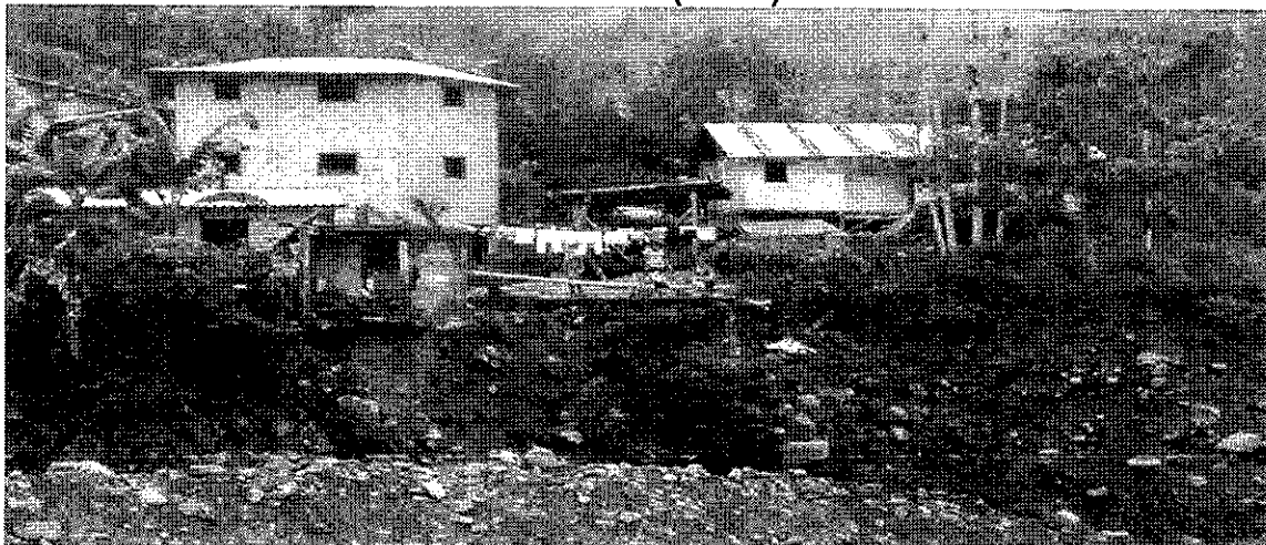
Vivienda del Sr. Manuel Trujillo ubicada en la ribera izquierda del Río Dulcepamba (foto 9)
