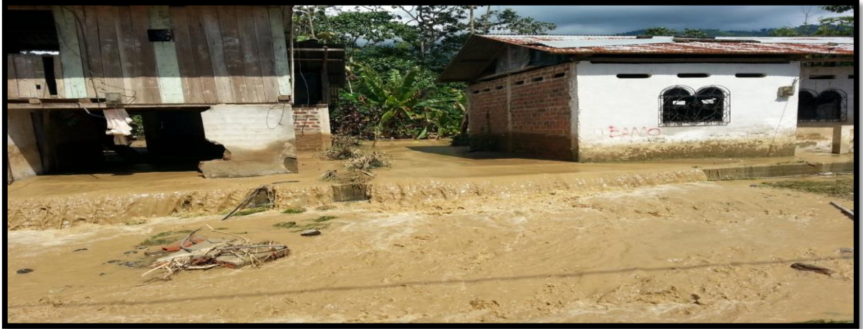
Foto # 7 Sector Barrio San José se observa el río desbordado
