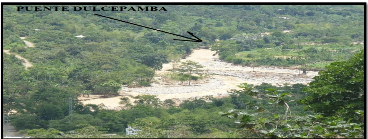
Foto # 9 Vista panorámica del cauce del río aguas abajo del proyecto Hidrotambo
