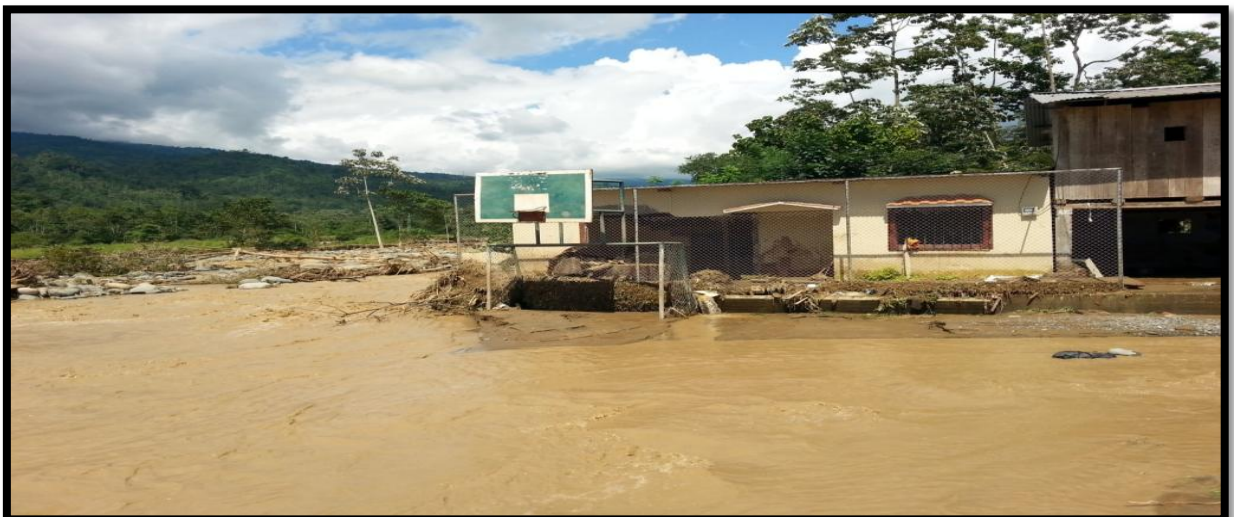
Foto # 8 Sector Barrio San José se observa el río desbordado
