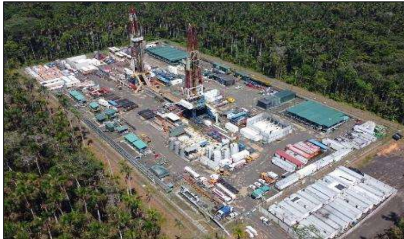
Figura 4 Plataforma Ishpingo B
