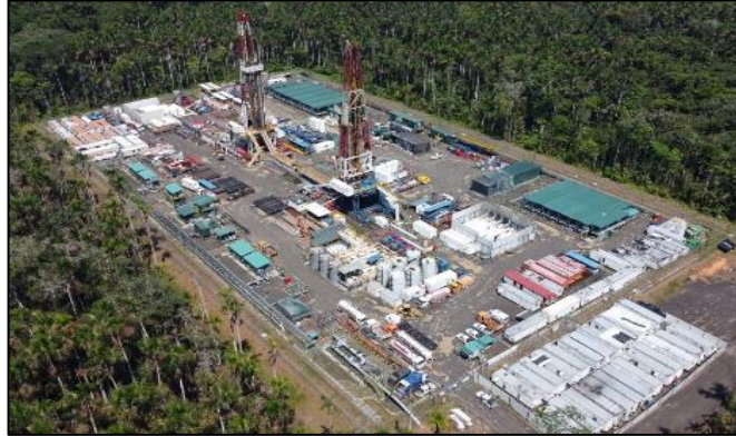
Figura 4 Plataforma Ishpingo B
