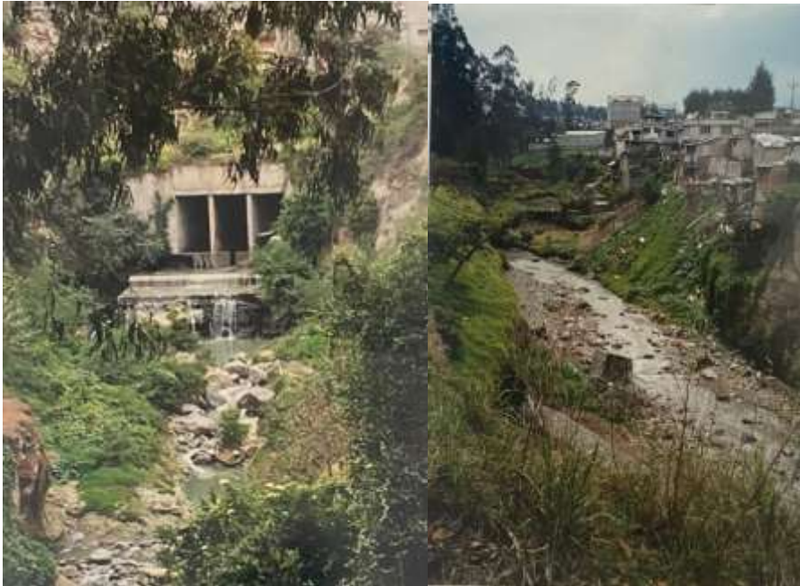
Colector El Colegio y río Monjas tramo la Esperanza. 1990 Fuente: Amicus curiae José Monge
