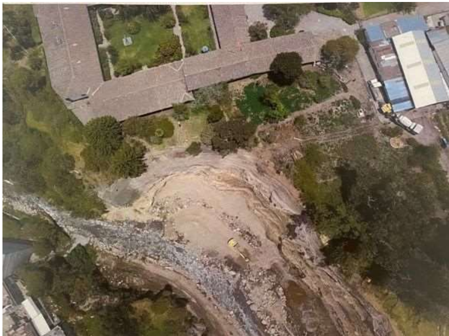
Casa Hacienda Carcelén y quebrada El Colegio/ río Monjas. Año 2021 Fuente: Amicus curiae José Monge
