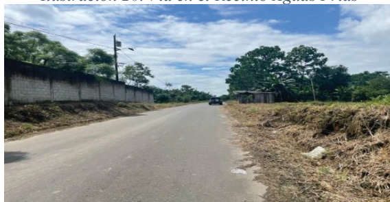
Ilustración 20. Vía en el Recinto Aguas Frías
