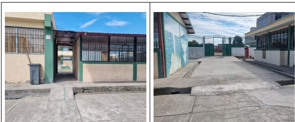
Infraestructuras inclusivas (rampas de acceso) Unidad Educativa Ignacio Flores de la Parroquia Antonio José Holguín
