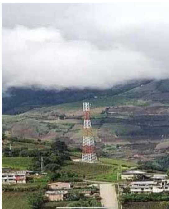
Fuente: Base fotográfica de equipo PDYOT 2023
