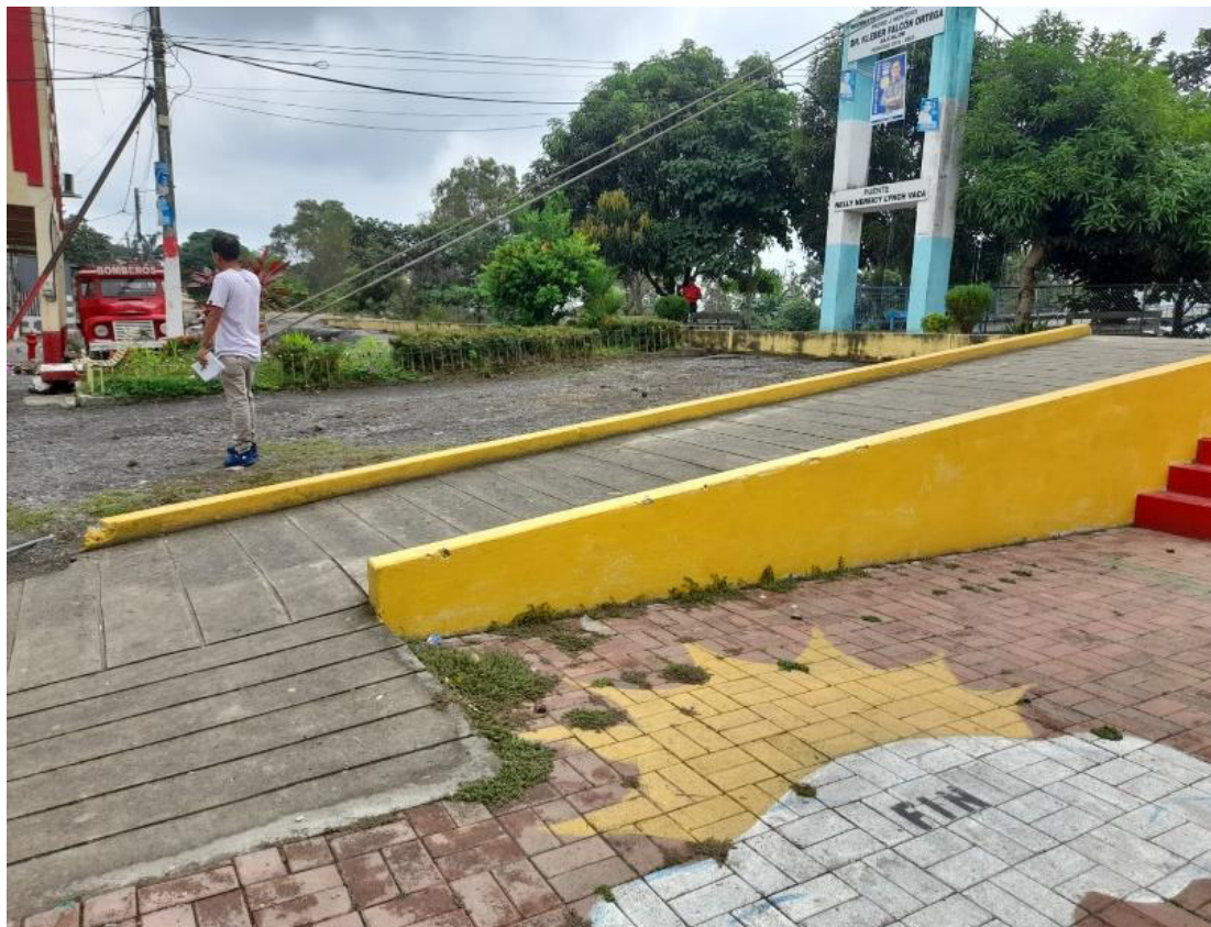
Gráfico 7: Rampa para acceso de discapacitados, elemento inclusivo en el Malecón de Gral. Pedro J. Montero (Boliche)
