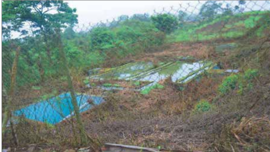
FOTO 19. Planta de tratamiento de Aguas Residuales Cabecera parroquial La Libertad
