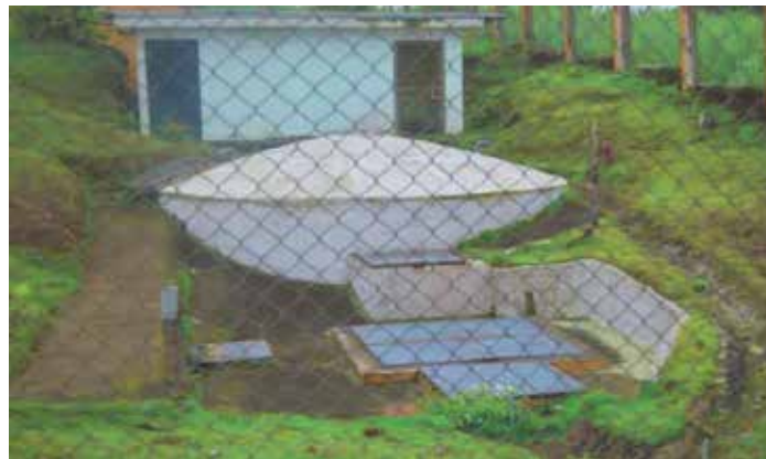
FOTO 16. Planta de Tratamiento de Agua Potable
