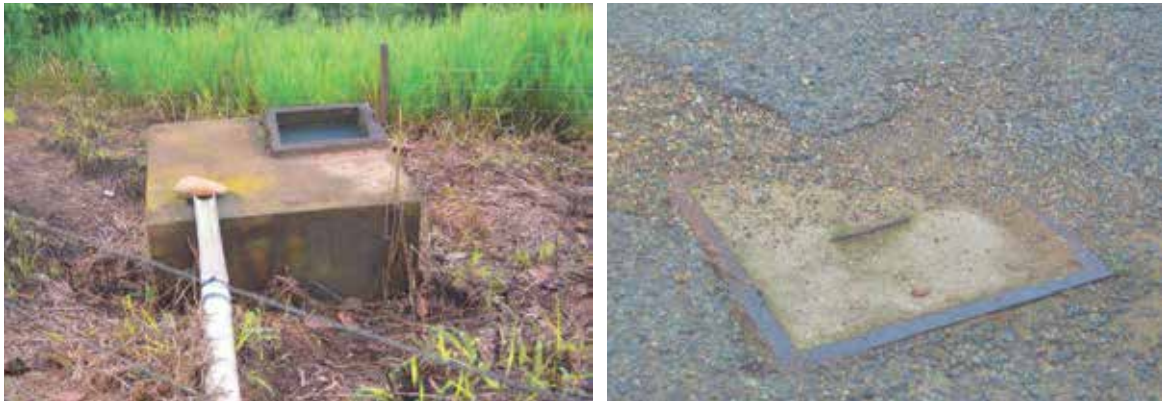
FOTO 18. Alcantarillado Cabecera Parroquial La Libertad
