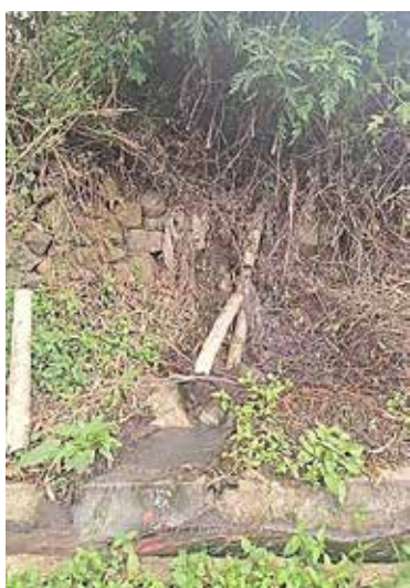
Fotografía 2. Aguas servidas vertidas al canal riego
