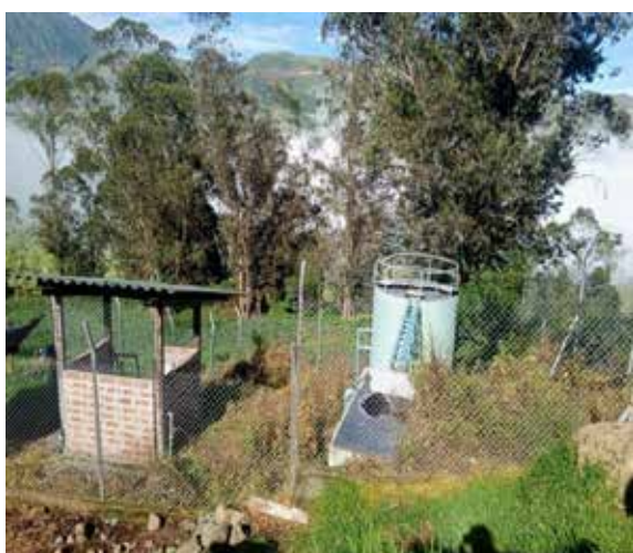
Fotografía 1. Planta de tratamiento de la Cabecera Parroquial
