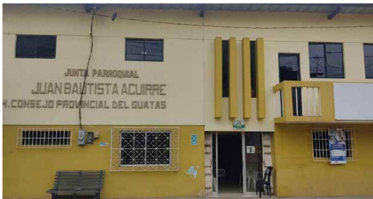
Ilustración. N° 3 Edificio del GAD Parroquial Juan Bautista Aguirre Fuente: GAD Los Tintos Elaborado: Equipo Consultor PDOT 2023 – 2027
