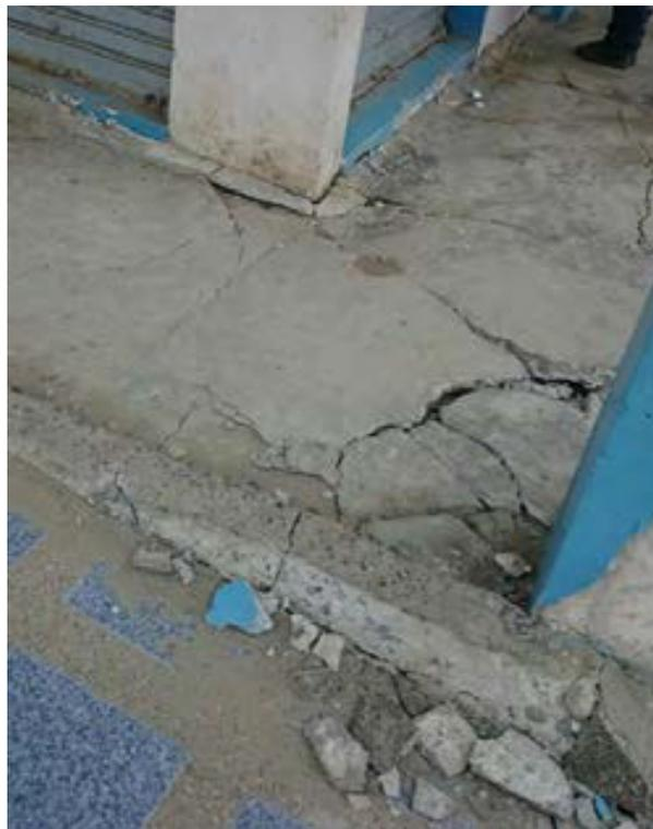
Figura 166: **Hundimiento de cimentación. Muisne, Ecuador 2016.**
