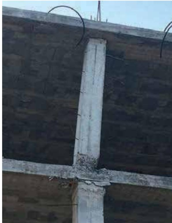
Figura 171: **Edificación fuera de aplomo. Terremoto de Pedernales, Ecuador 2016.**
