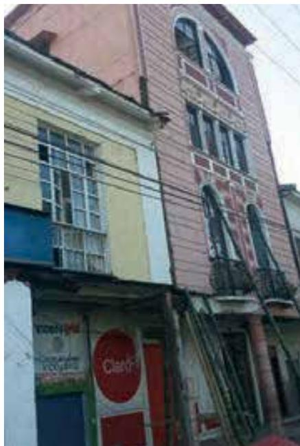
Figura 172: **Edificación fuera de aplomo, se puede observar apuntalamiento por seguridad. Bahía, Ecuador 2016.**
