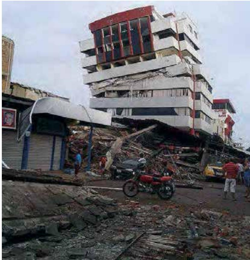
Figura 163: **Colapso total de la estructura. Portoviejo, Ecuador 2016.**
