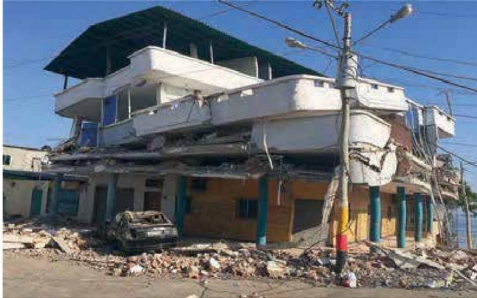
Figura 159: **Colapso total de la estructura. Terremoto de Portoviejo, Ecuador 2016.**
