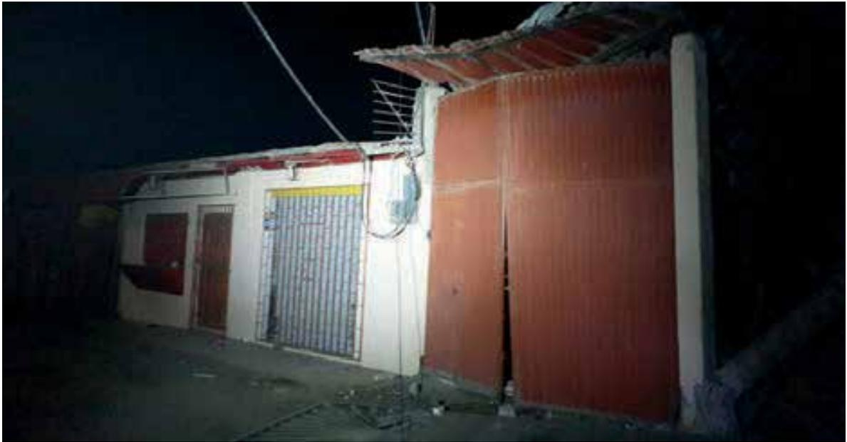
Figura 183: **Cubierta de garaje amenaza caer. Terremoto de Pedernales, Ecuador 2016.**
