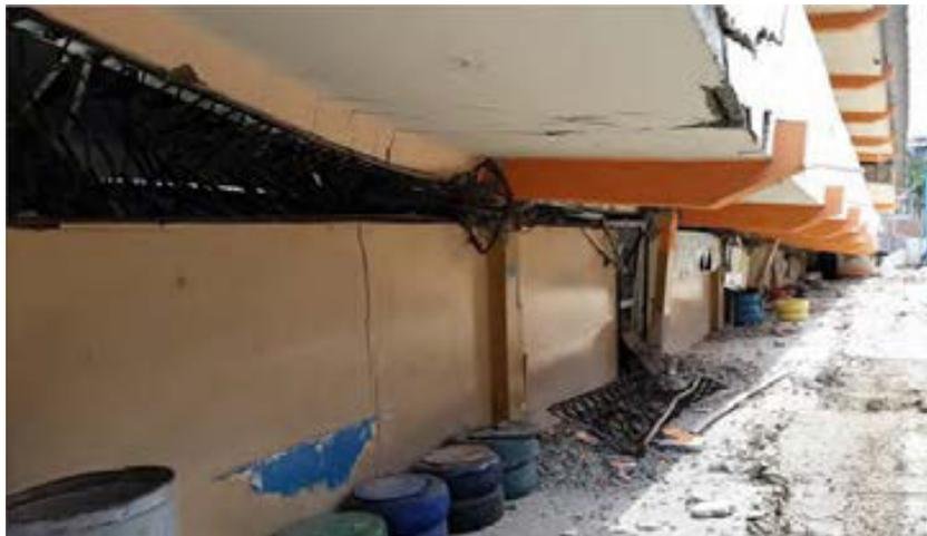
Figura 22: **Columnas cortas: Confinamiento lateral de paredes**
