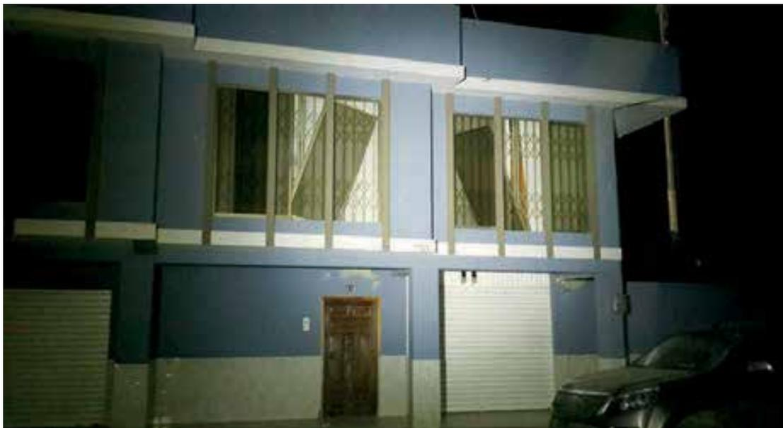
Figura 182: **Ventanas corren riesgo de caer. Terremoto de Pedernales, Ecuador 2016.**
