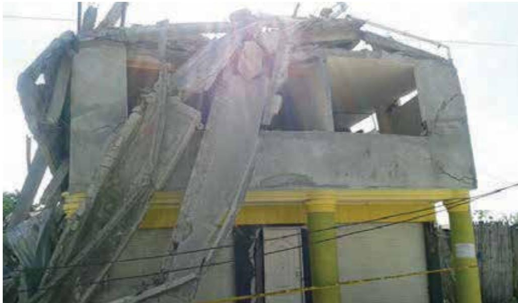
Figura 164: **Colapso total de la estructura. Terremoto de Pedernales, Ecuador 2016.**
