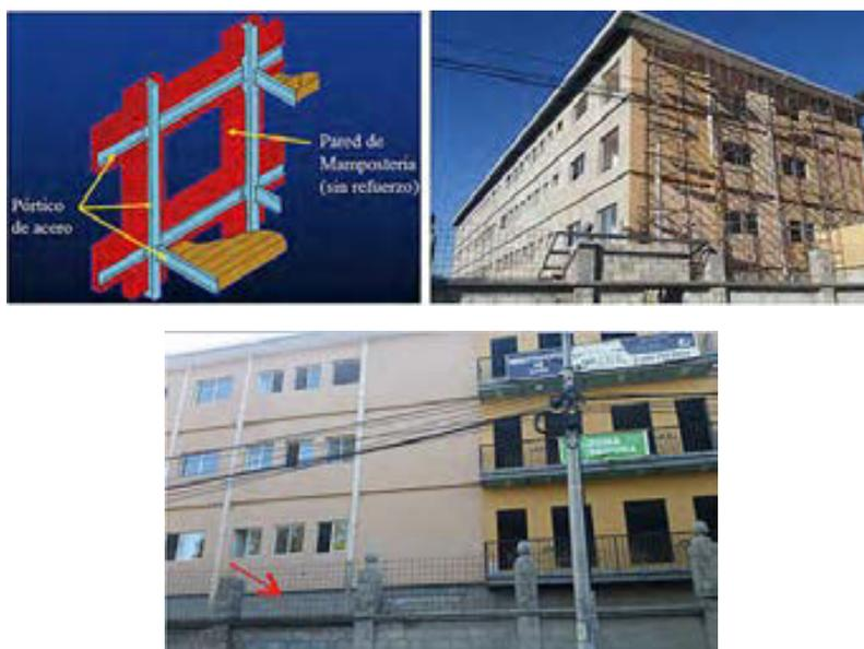
Figura 125: Tipo de sistema estructural: **Pórtico de acero con paredes de mampostería (S5)**.
