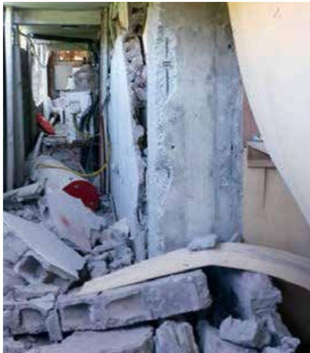
Figura 190: Tanque de propano fuera de su base. Cercar el área insegura. Canoa, Ecuador 2016.
