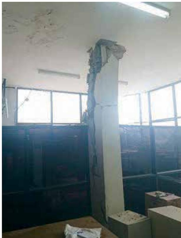
Figura 174: Daños severos en columna interna. Terremoto de Pedernales, Ecuador 2016.
