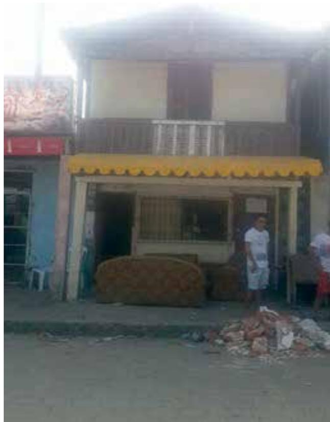
Figura 170: **Edificación fuera de aplomo. Terremoto de Pedernales, Ecuador 2016.**
