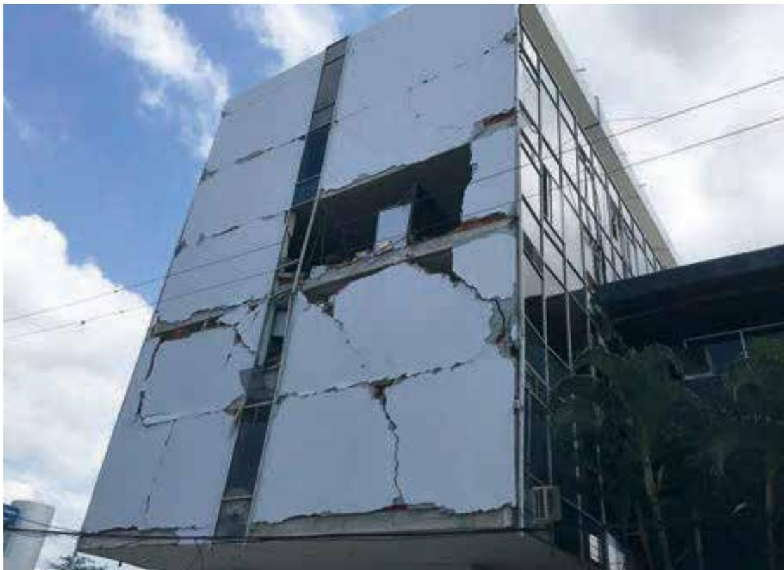
Figura 177: Grietas grandes en paredes u otros daños severos. Señalizar Inseguro. Terremoto de Pedernales, Ecuador 2016.
