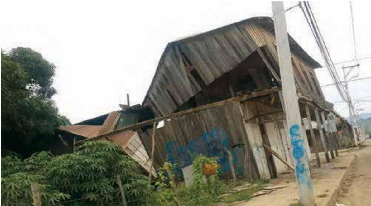
Figura 162: **Colapso parcial de la estructura. Jama, Ecuador 2016.**
