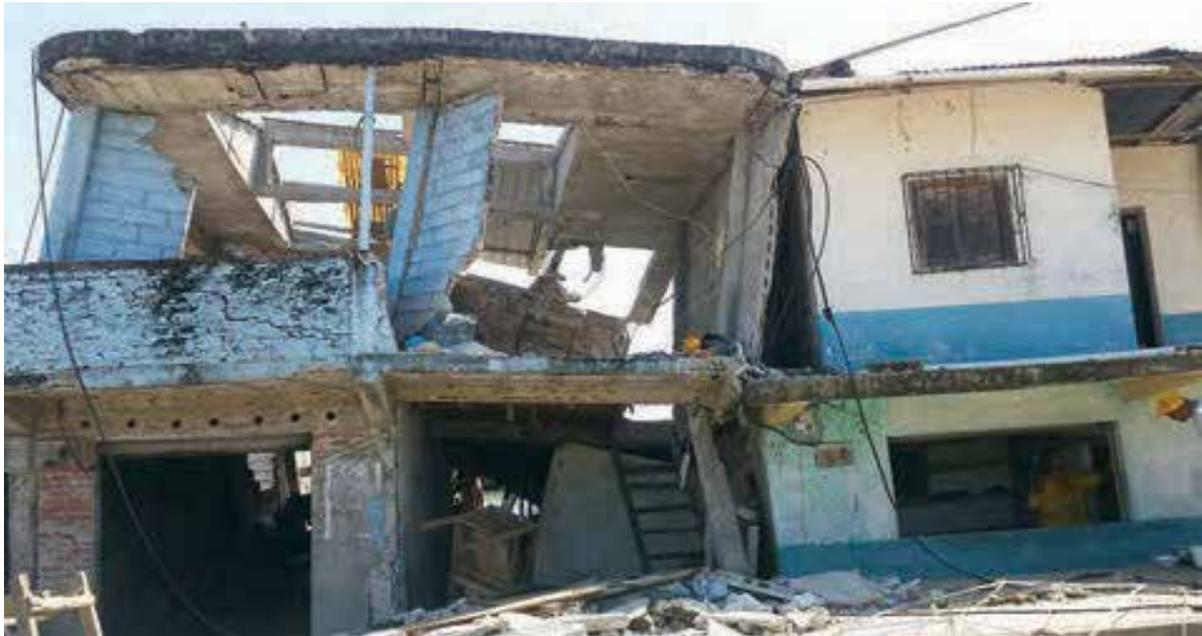
Figura 169: **Edificación fuera de aplomo. Terremoto de Pedernales, Ecuador 2016.**
