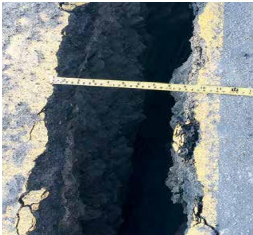
Figura 188: **Separación de la calzada por movimiento de suelos. Manabí, Ecuador, 2016**
