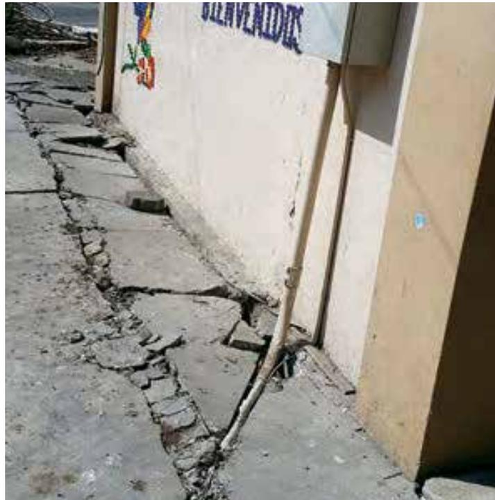
Figura 165: **Cimentación afectada por problemas geotécnicos. Manta, Ecuador 2016.**
