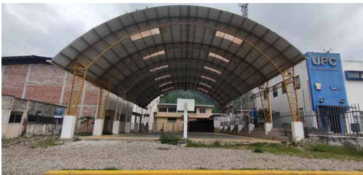
Imagen 6. Equipamiento de recreación.
