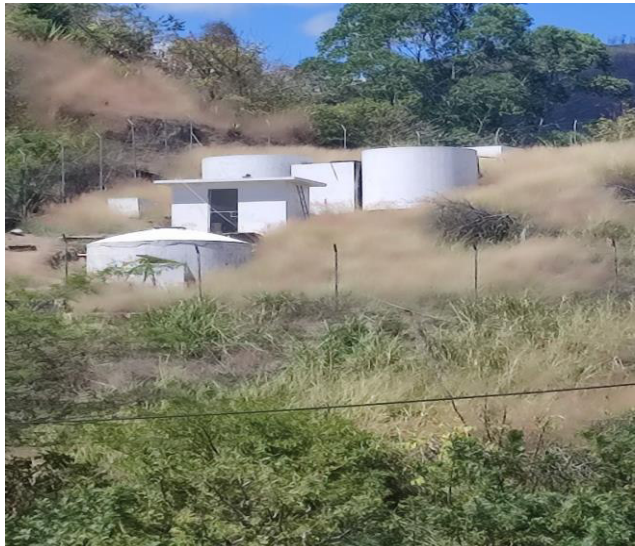
Imagen 32. Sistema de agua potable y entubada en el barrio Rancho Alegre – Sacapalca Nota. Fotografía tomada en estudio de campo por Equipo Técnico Consultor (2024).
