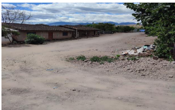
Imagen 30. Vía "Y Piñonales – Pilancay" - Sacapalca
