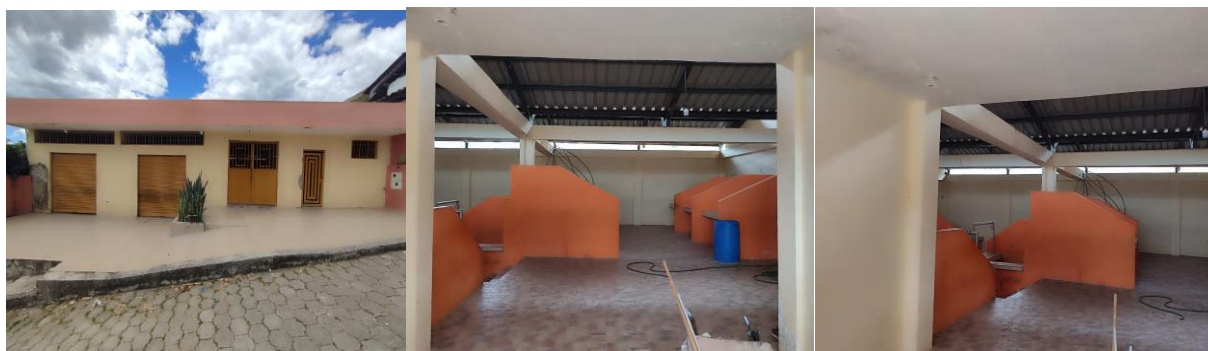
Imagen 25. Infraestructura del Mercado parroquial de Sacapalca
