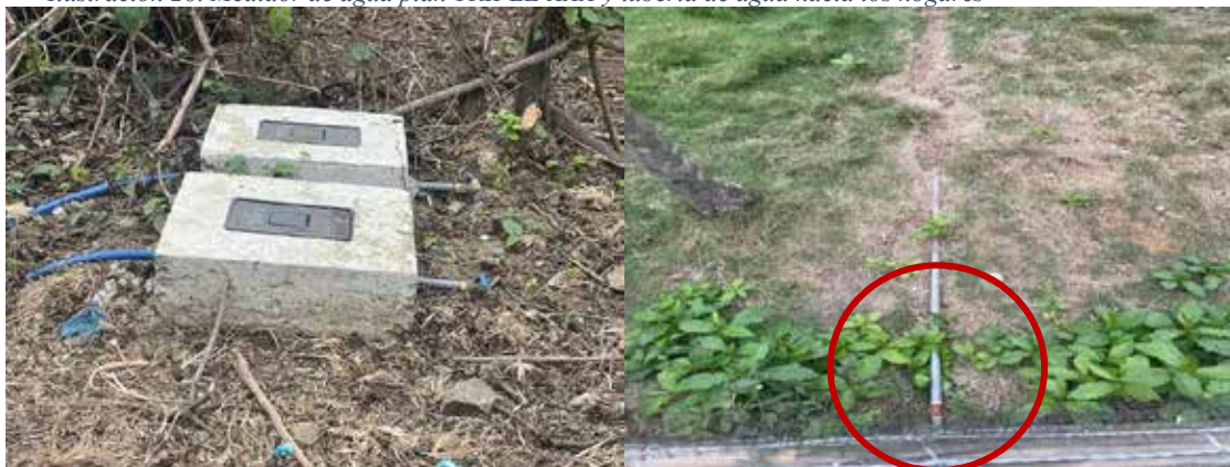
Ilustración 28. Medidor de agua plan TRIPLE AAA y tubería de agua hacia los hogares
