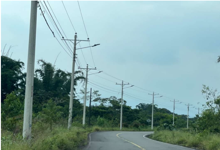
Img6. Cobertura red eléctrica
