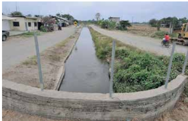
Gráfico 41: Infraestructura destinada al riego
