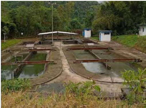
Foto 4- Planta de Tratamiento de Aguas Servidas de Mindo
