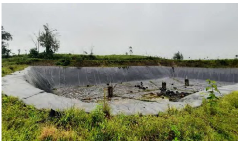
ILUSTRACIÓN 4. CELDA DE DISPOSICIÓN FINAL DE RESIDUOS
