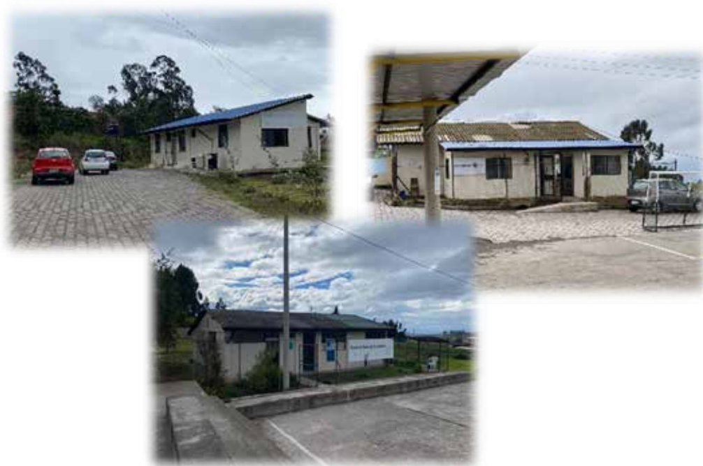
Fotografía 13. Subcentro y Puestos de salud en la Parroquia San Isidro de Patulú
