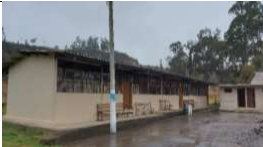
Cancha Encementada (en reconstrucción)
