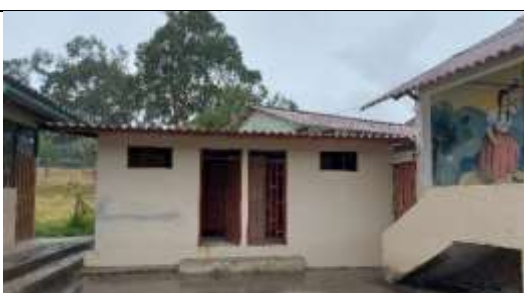
Cancha Encementada (en reconstrucción)
