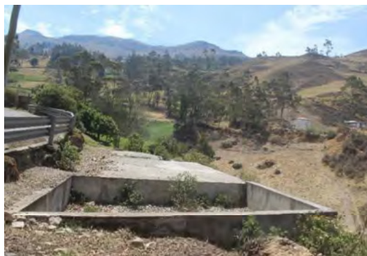
Foto 62. Tanque de oxidación de la Cabecera Parroquial de San José de Achupallas.
