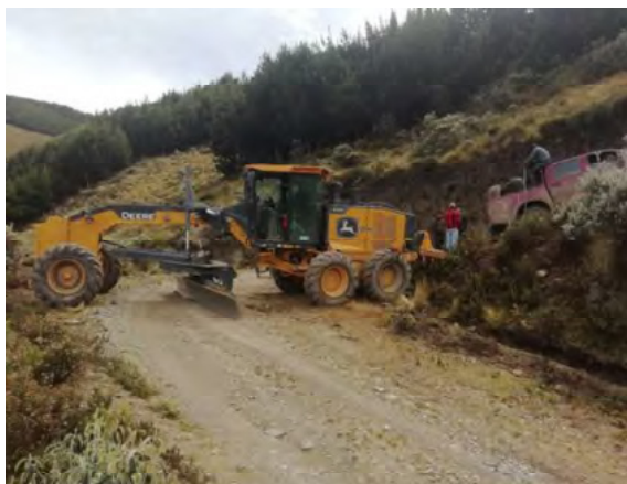
Foto 53. Motoniveladora realizando el mantenimiento de la vía Chipcha-Totoras
