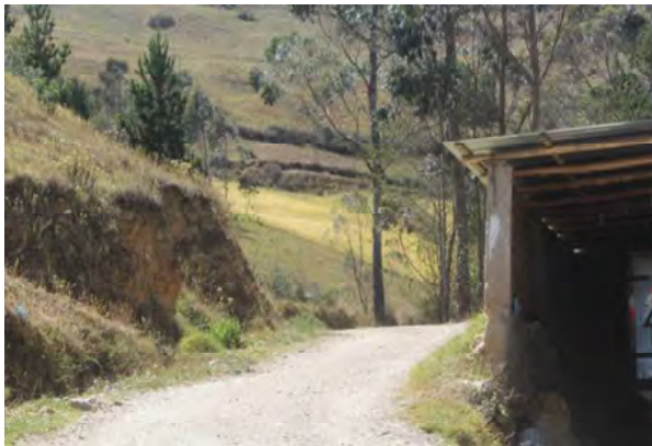
Foto 52. Vivienda construida sin respetar el derecho de vía
