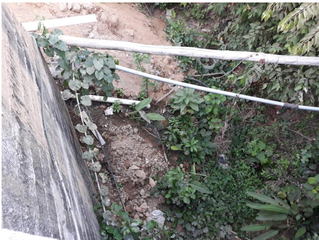
Figura 12. Mala conexión de tuberías de agua residuales Elaborado por: Equipo técnico de la actualización del PDOT
