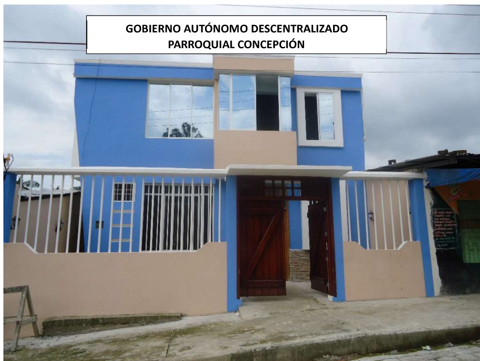
Imagen 18. Edificación del GAD parroquial
