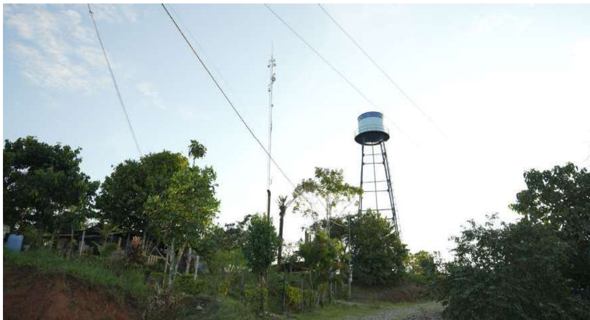
Fotografía 16. Tanque elevado - Puerto Nuevo
