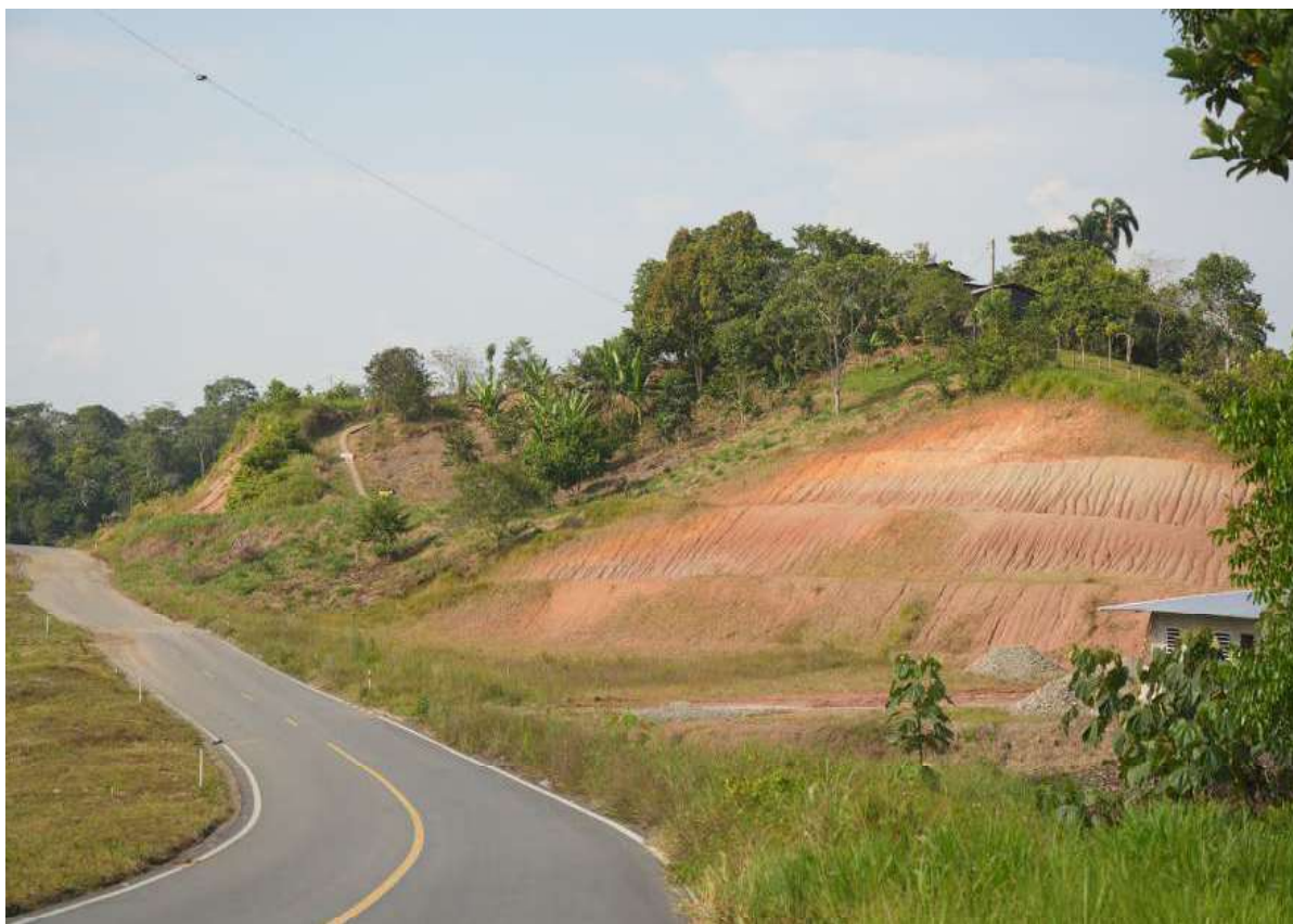
Fotografía 7. Erosión de suelos – Sector Juan Montalvo
