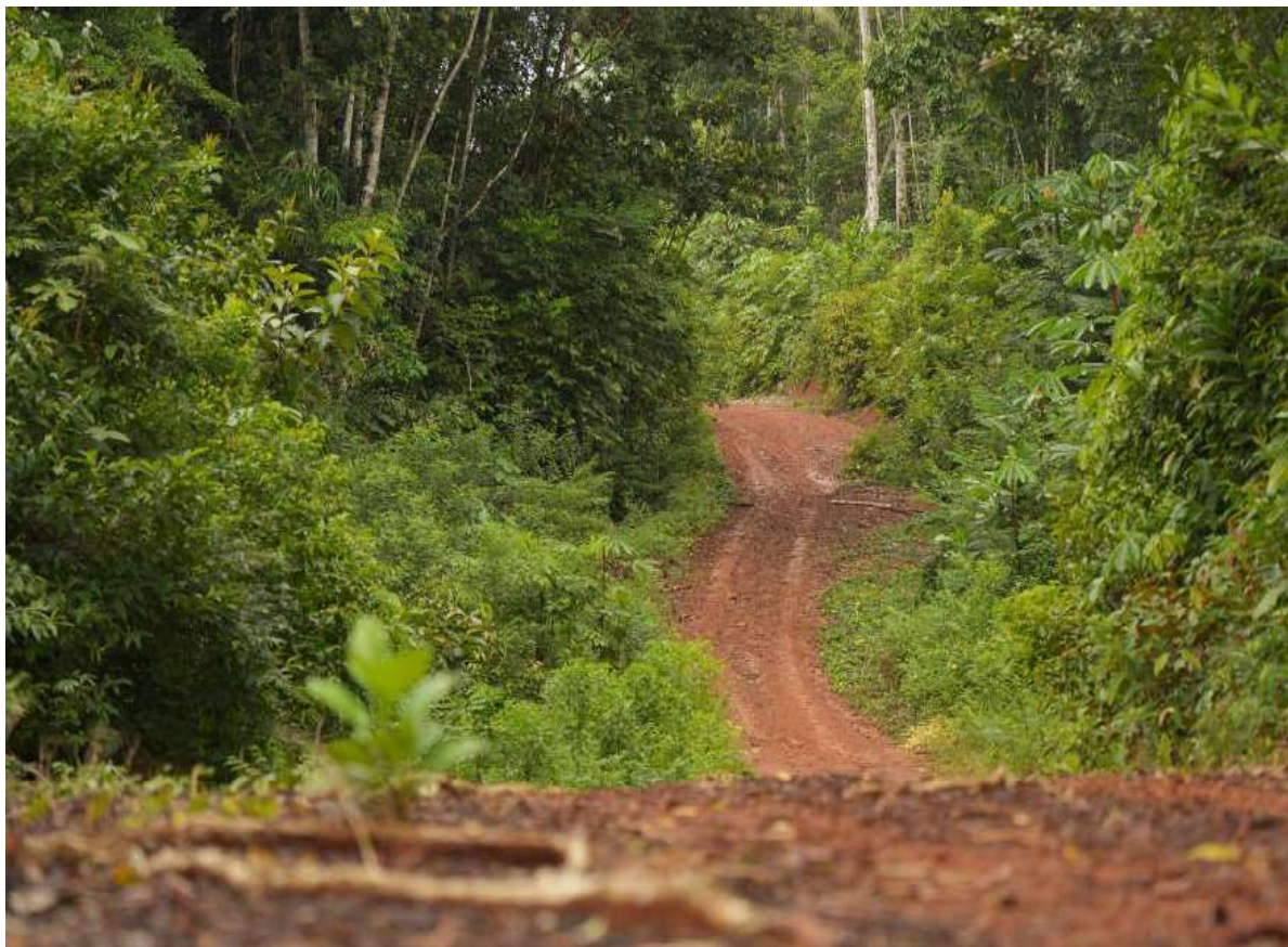
Fotografía 10. Vías de tierra en Pacayacu – Sector Las Golondrinas
