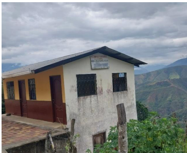
Figura 7. Infraestructura del Mercado, parroquia rural La Chonta
