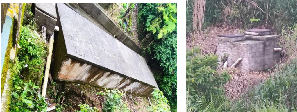
Fotografía 3. Cajas de revisión sin mantenimiento
