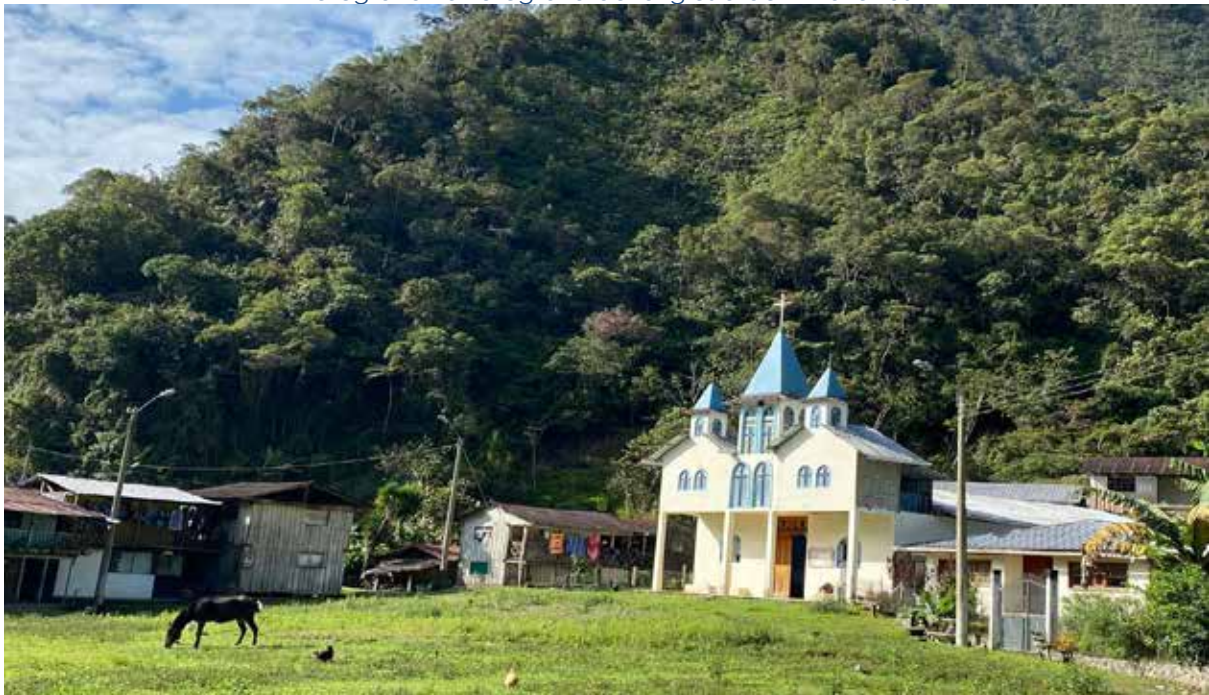
Fotografía 18 Fotografía de la Iglesia de Amazonas
