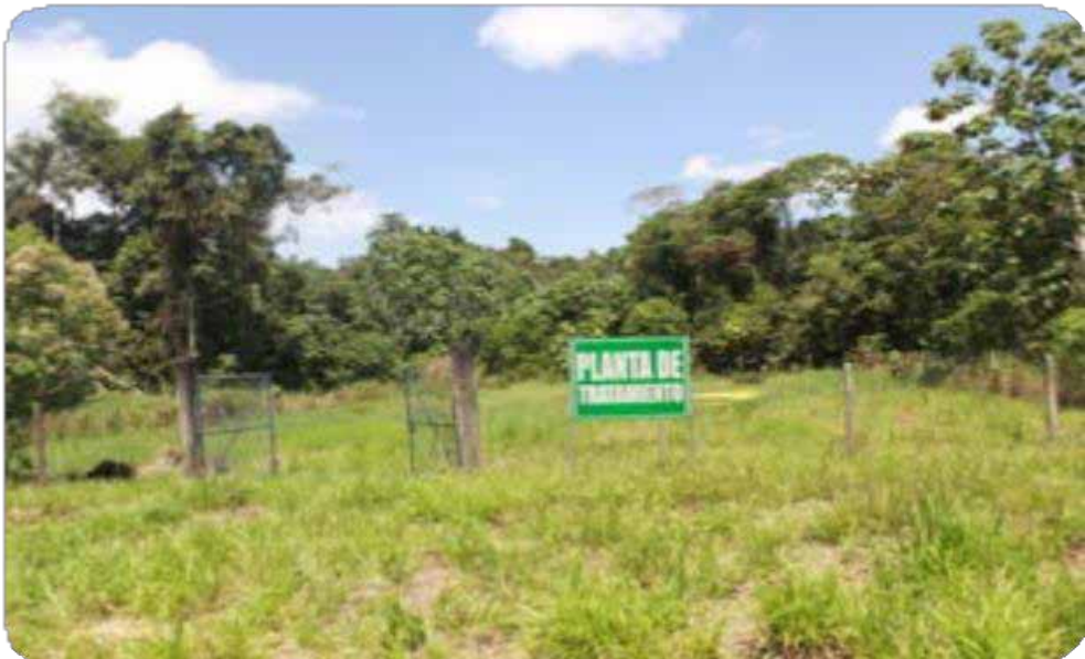
Figura 38. Planta de tratamiento de aguas residuales.
