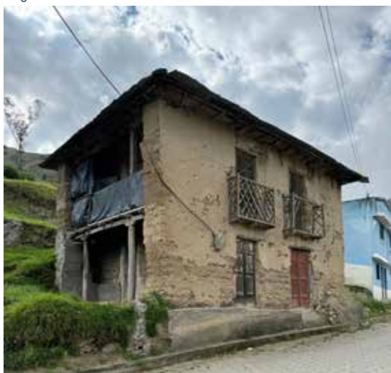
Figura 52: Construcción tradicional del centro de Angamarca
