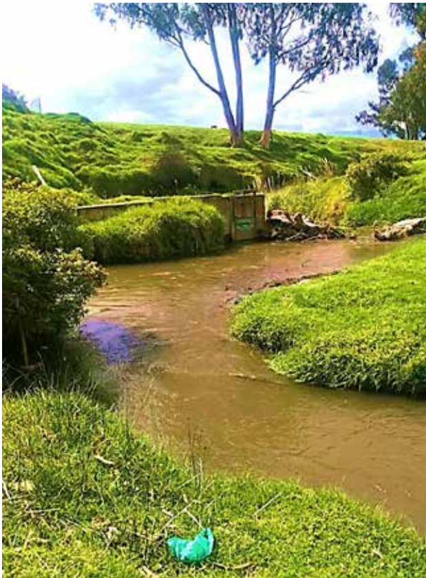
Fuente. Levantamiento de campo
