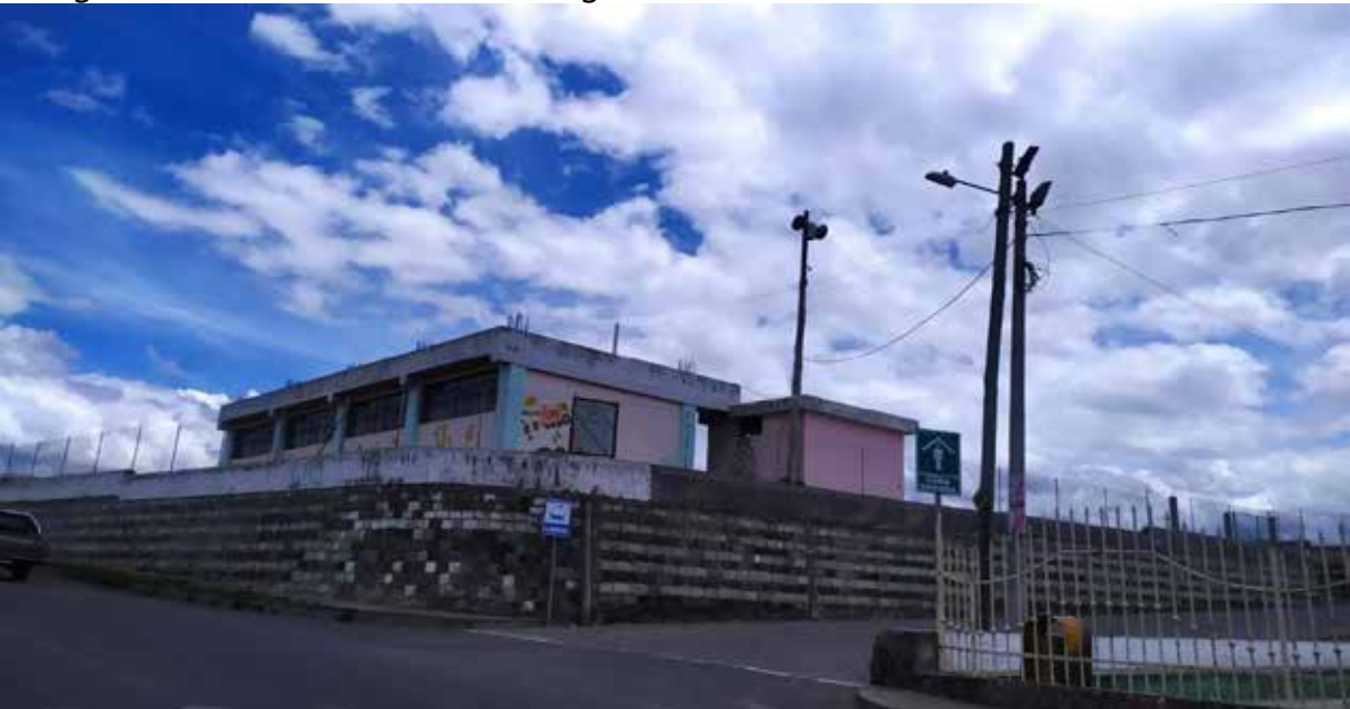
Fotografía 4. Abastecimiento de energía eléctrica
