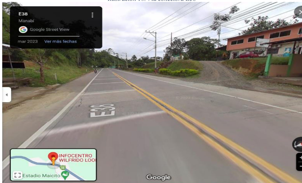
Ilustración 10. Vía conectora E38
