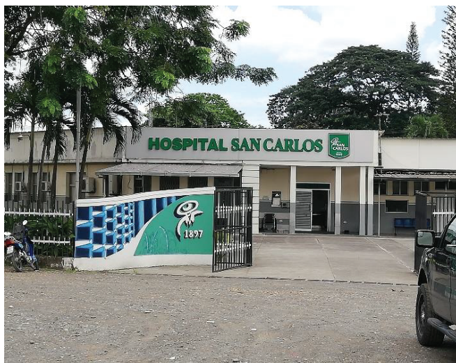
Hospital Particular San Carlos, en el Área Urbana
