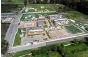
Imagen 49: Unidades Educativas construcción mayor.
