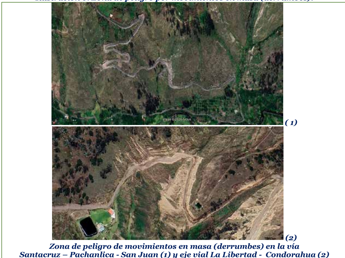
Ilustración 6. Zona de peligro por movimientos en masa (derrumbes).
