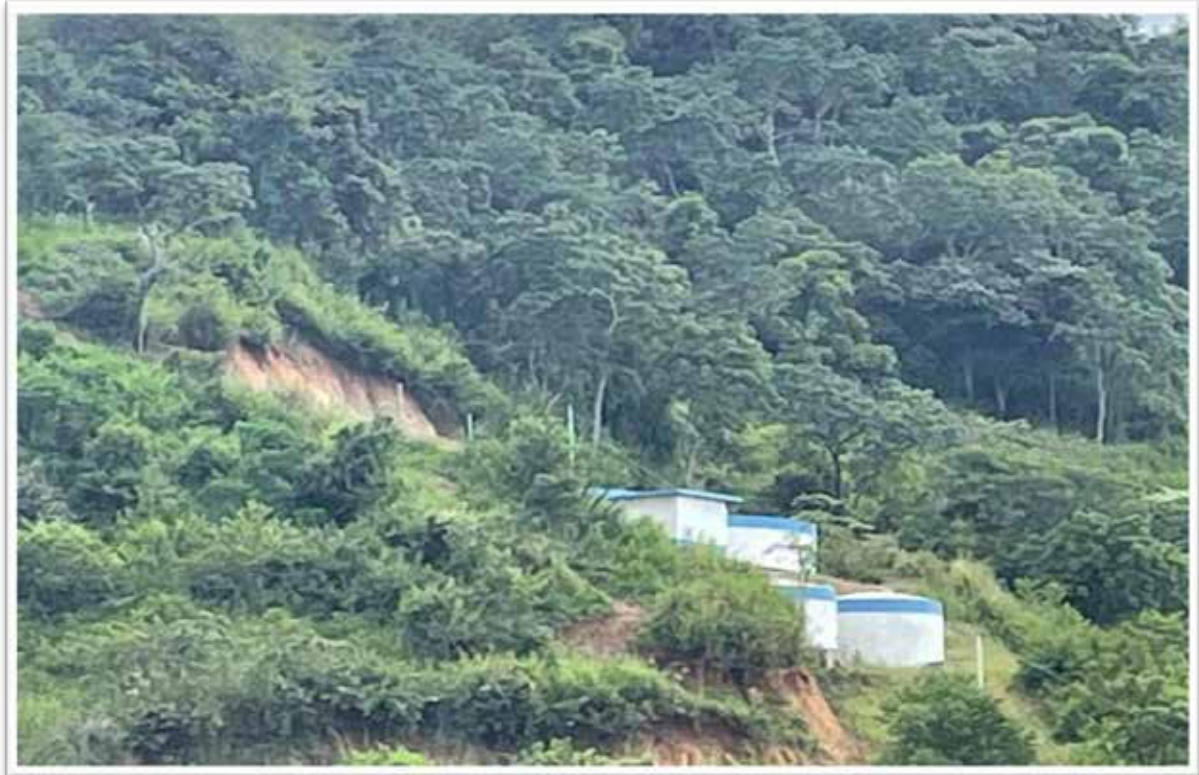
FOTO 41. PLANTAS DE AGUA POTABLE DE LA PARROQUIA
