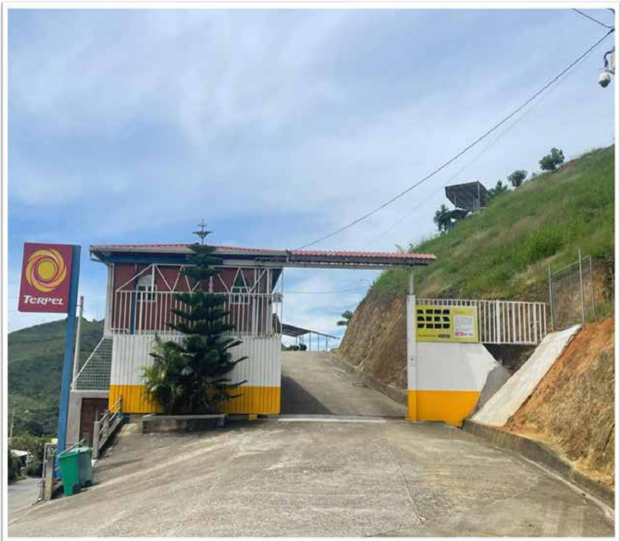
FOTO 18. DISTRIBUIDOR DE COMBUSTIBLE
