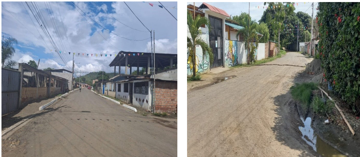
Ilustración 6. Estado vial Recinto Puerto Rico
