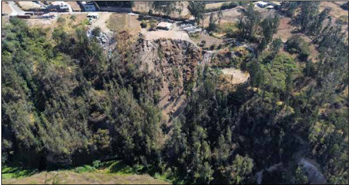
Imagen 11. Botadero de escombros
