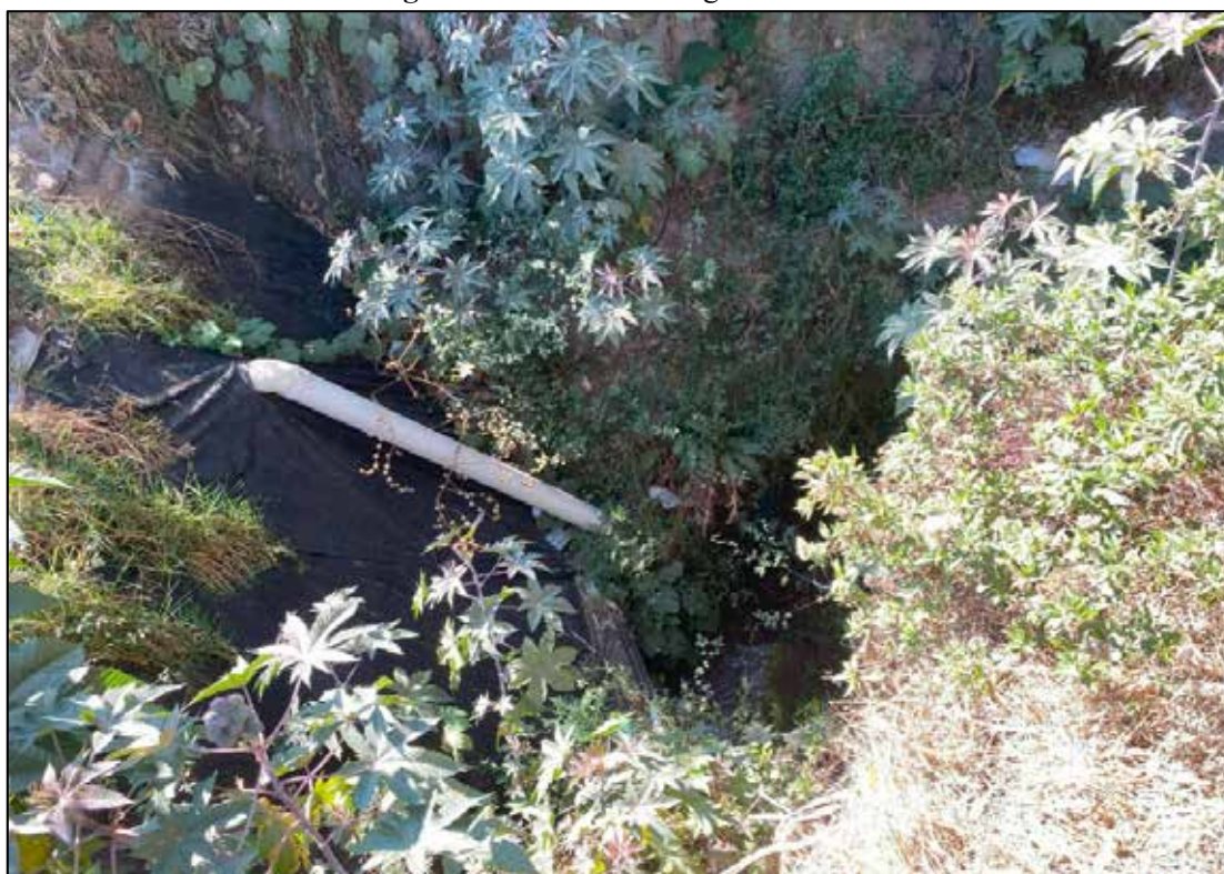
Imagen 8. Contaminación aguas residuales
