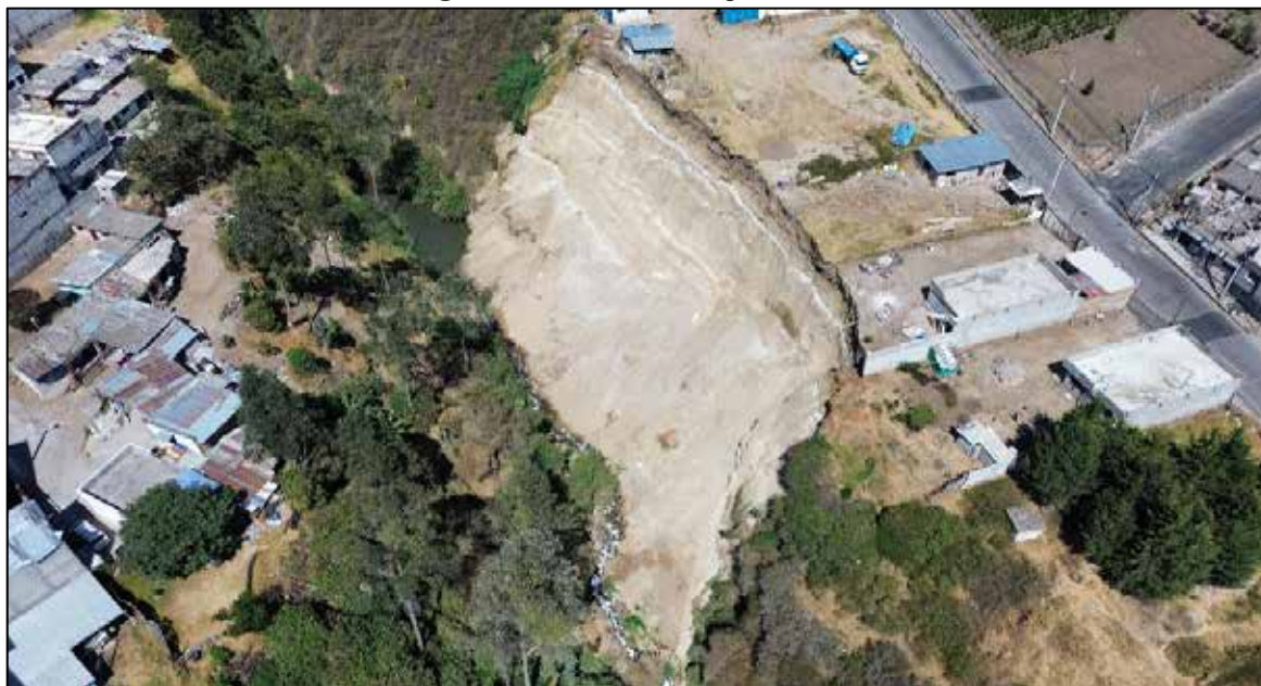
Imagen 14. Deslizamiento quebrada Seca
