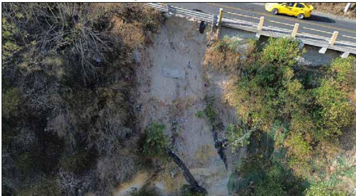
Imagen 12. Botadero de escombros
