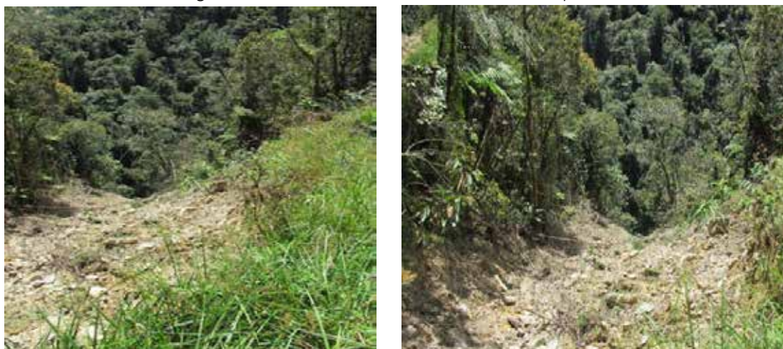
Fotografía 2 Deslizamiento en la zona alta de la captación
