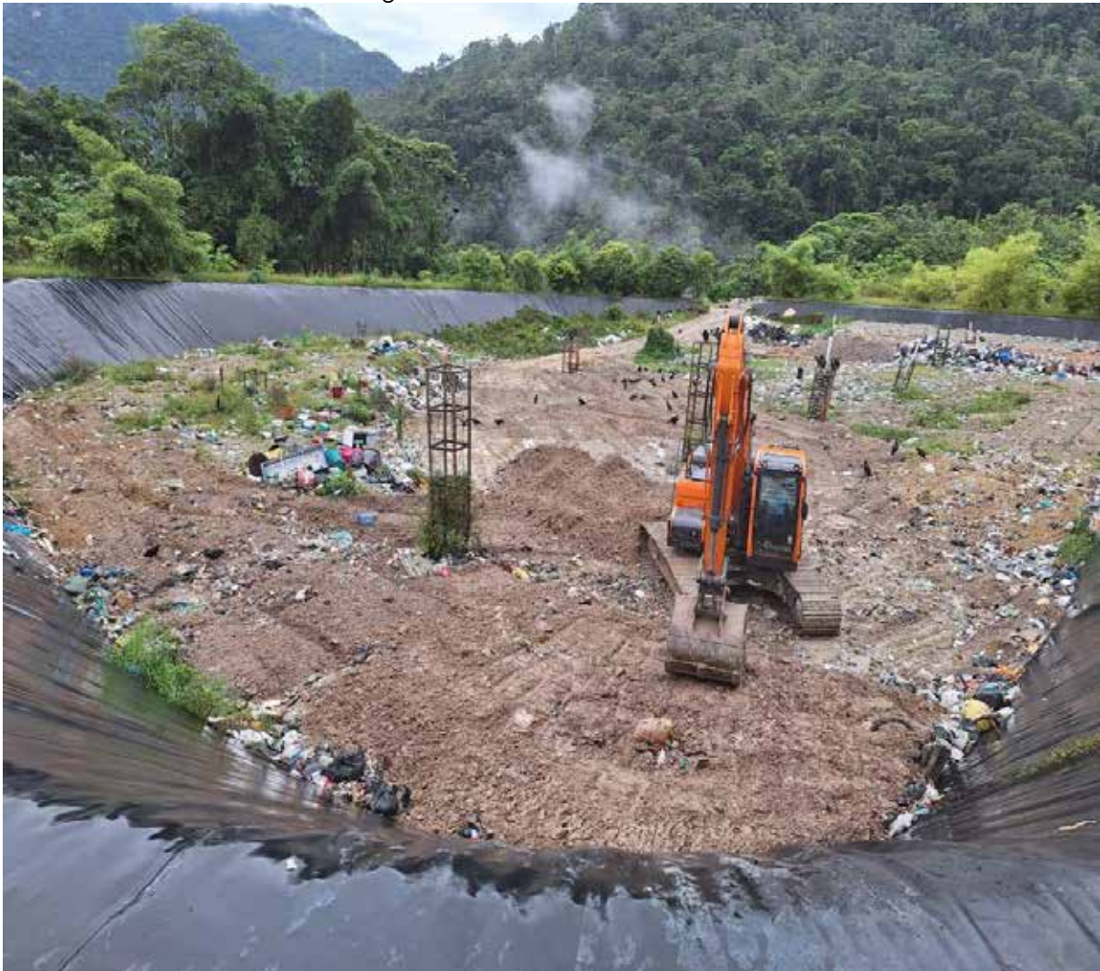
Fotografía 1 Celda actual relleno sanitario
