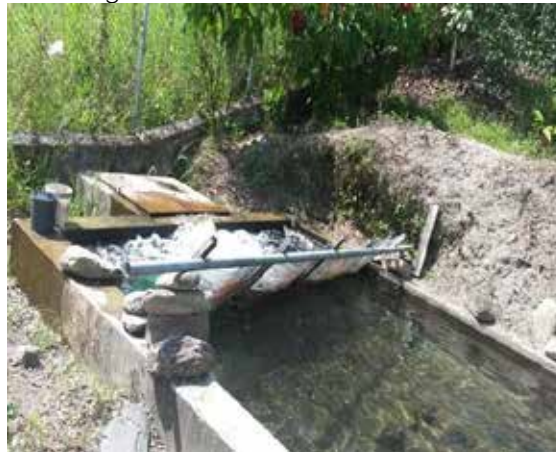
Fotografía 3 Filtro Dinámico del sistema de agua de General Plaza.
