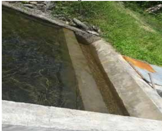
Fotografía 3 Filtro Dinámico del sistema de agua de General Plaza.
